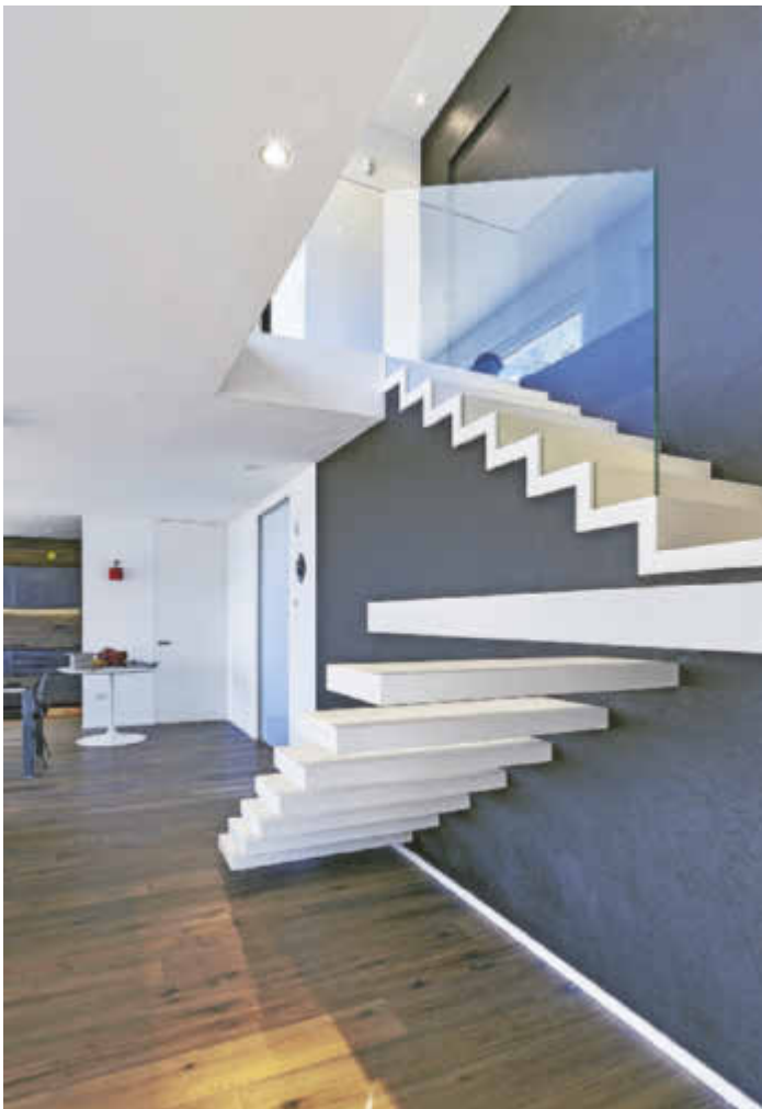
/ Maximale Transparenz: Das Geländer am oberen Treppenlauf aus weißem VSG-Glas ist auf die faltwerkstufen aufgesetzt.
