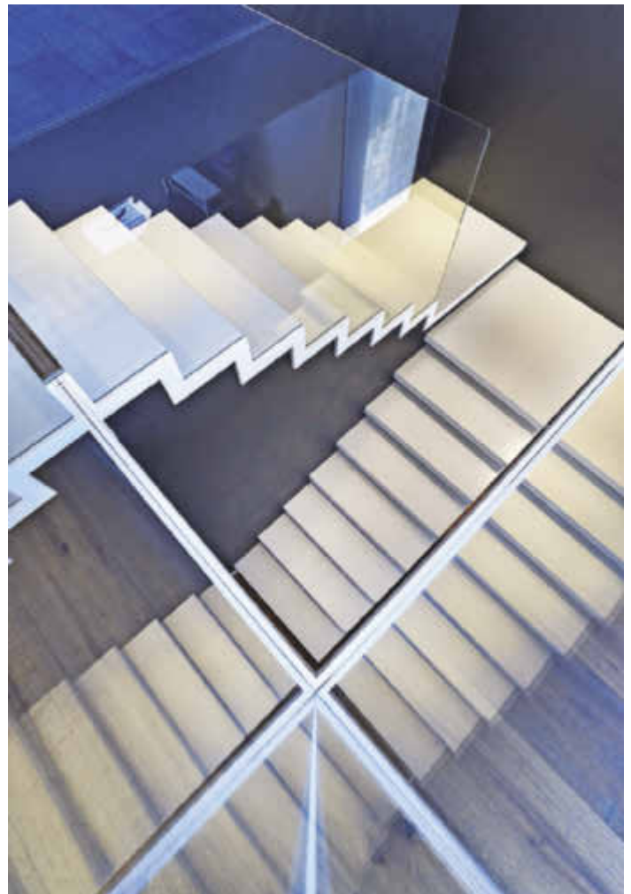
/ Exakter Zusammenlauf: Das gläserne Treppengeländer geht im Obergeschoss in die umlaufende Brüstungsverglasung über.
