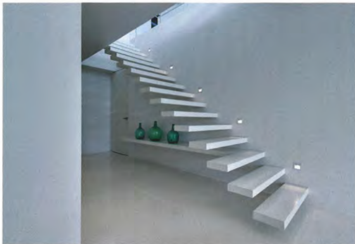
/ Eleganter Aufstieg: Vom Untergeschoss des Wohnhauses führt eine geländerlose Kragarmtreppe aus weißem Mineralwerkstoff in den Wohnbereich.
