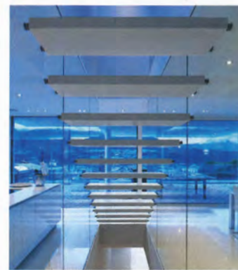
/ Zwischen Glas eingespannte Stufen sorgen für maximale Transparenz.
