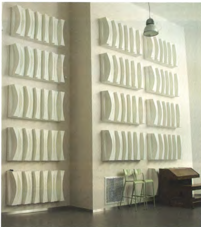
In individuell gegossenen Sonderformen sorgt der Mineralwerkstoff Varicor als Akustikpaneel in einem Konzerthaus für den richtigen Ton.
