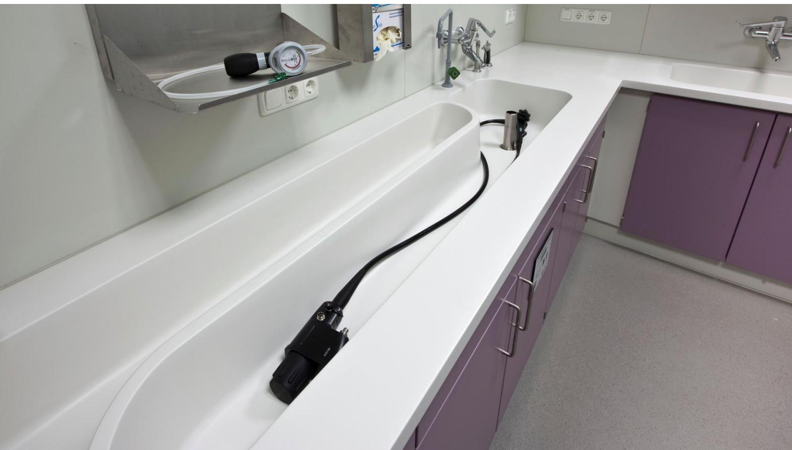
Durch die Beckenabmessung von 1849 x 400/175 mm und einer Tiefe von 187 – 206 mm ermöglicht das **Endoskopbecken** die einfache, sichere und durch die gestreckte Lagerung zugleich schonende Aufbereitung von Endoskopen. Das eingearbeitete Gefälle im Boden sorgt für vollständiges Abfließen der Flüssigkeit. Dadurch werden optimale Hygieneergebnisse erzielt.
